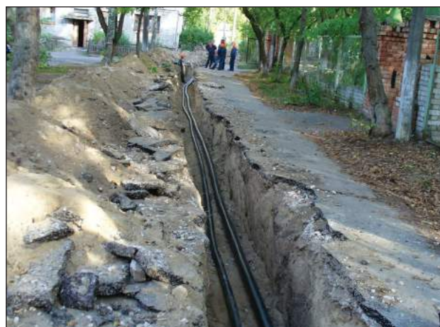
Рис. 6. Трубопроводы ГВС из сшитого полиэтилена типа «Изопрофлекс-А» в процессе монтажа.
