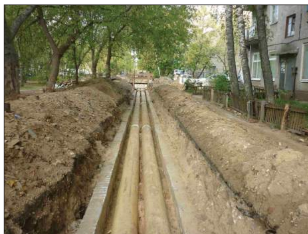
Рис. 8. Прокладка трубопроводов Ду300 мм в пенополимерминеральной изоляции.
