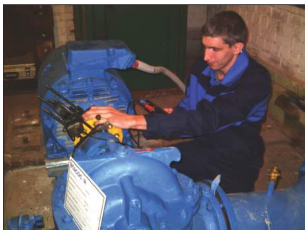
Рис. 7. Проведение центровки сетевого насоса.
