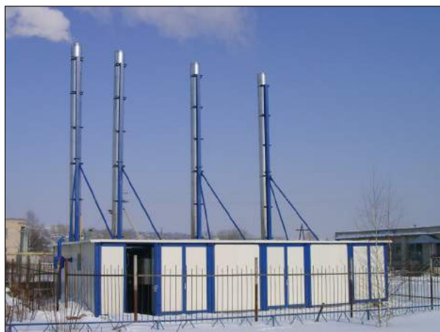
Рис. 2. Модульная котельная фирмы DHAL (Германия) мощностью 16 МВт в г. Сергач Нижегородской области.
